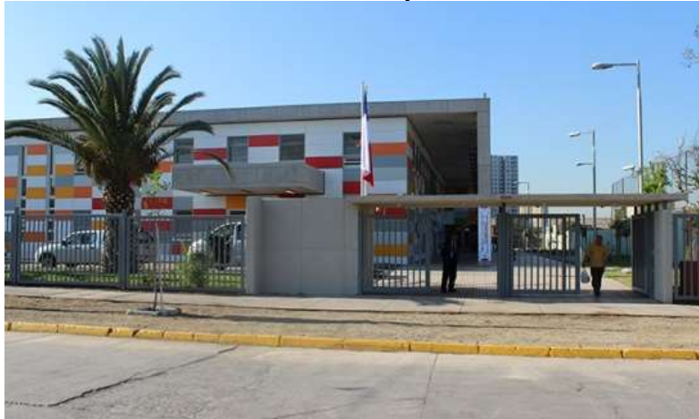
Fuente: Street view
