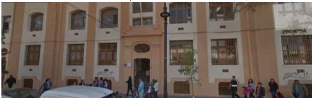
Fuente: Street view
